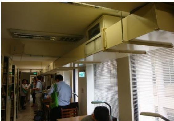
引入外氣直接進入落地型空調箱之改善案例
