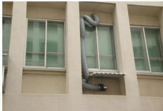
引入外氣直接進入落地型空調箱之改善案例
