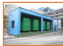
化工廠廢水以 EDR脫鹽回收 做為冷卻水塔 補充水 (800 m 3 /day)
