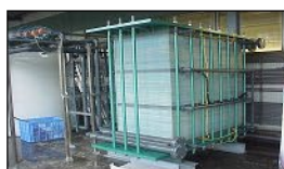
電子廠RO濃 縮水利用EDR 脫鹽回收至工 業水槽 (300 m 3 /day)
