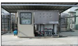
地下水利用EDR 脫鹽回收做為沖 洗水 (50 m 3 /day)
