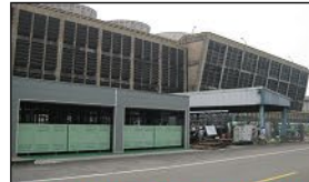
熱軋單元直接排 放冷卻水以EDR 脫鹽回收再利用 (550 m 3 /day)
