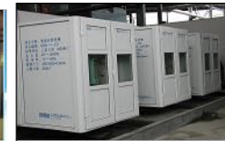
高導電度河川水 利用EDR脫鹽回 收做為製程用水 (2400 m 3 /day)
