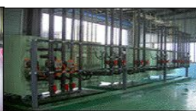
螺絲製造廢水利用 EDR脫鹽回收做為 清洗水 (450 m 3 /day)
