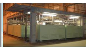
含氟廢水利用EDR 脫鹽回收做為洗滌 塔補充水 (1200 m 3 /day)
