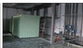
PCB廠製程清洗 廢水利用EDR脫 鹽回收做為冷卻 水塔補充水 (1200 m 3 /day)
