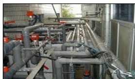
電子廠冷卻水以 EDR脫鹽回收 (550 m 3 /day)
