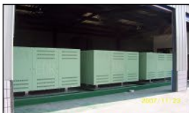
精密螺絲製造業 廢水以EDR脫鹽 回收再利用 (350 m 3 /day)
