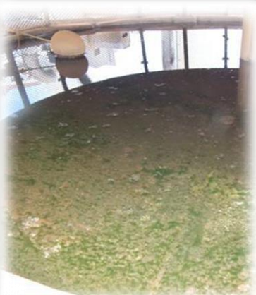
冷卻水塔之貯水池內藻類孳生情形
