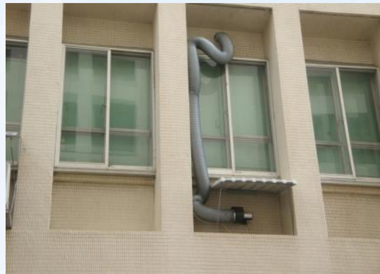
引入外氣直接進入落地型空調箱之改善案例
