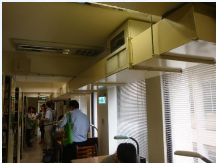
引入外氣直接進入落地型空調箱之改善案例
